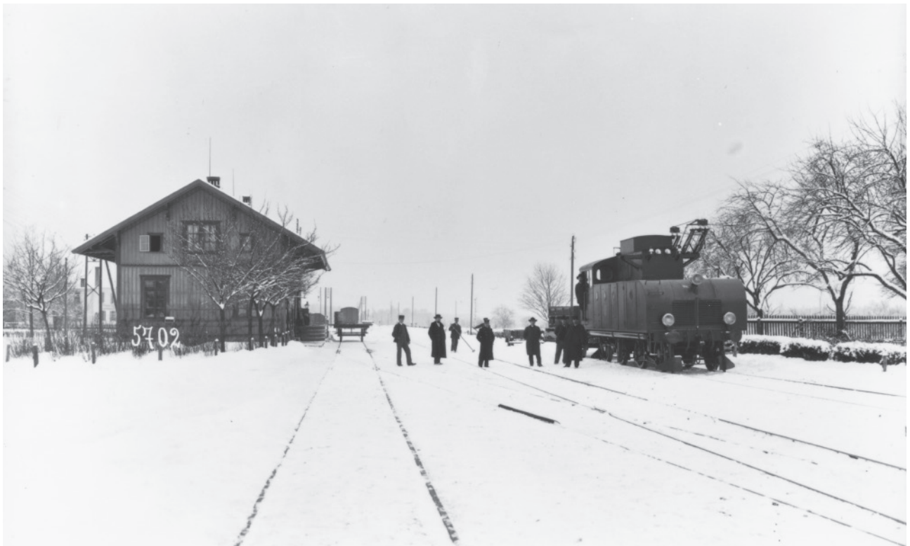
Elektrolok Ce 4/4 Nr. 1 Eva, Einphasenwechselstrom-Lokomotive der MFO. Versuchslokomotive Seebach–Wettingen auf Station Affoltern. Baujahr 1904. Bild: Verkehrshaus der Schweiz, Luzern
